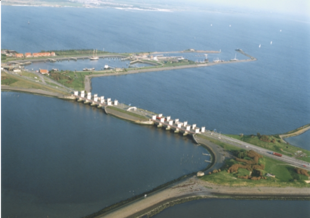
De Lorentzsluizen (bron https://beeldbank.rws.nl , Rijkswaterstaat)
