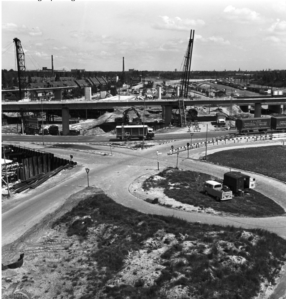
Aanleg knooppunt Kleinpolderplein 1969 (bron https://beeldbank.rws.nl , Rijkswaterstaat / Afdeling Multimedia)
