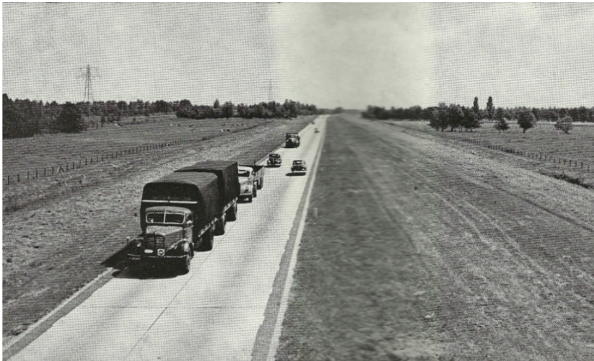
Rijksweg 12, km 80; richting Arnhem (bron Verslag Openbare Werken Waterstaat 1951)
