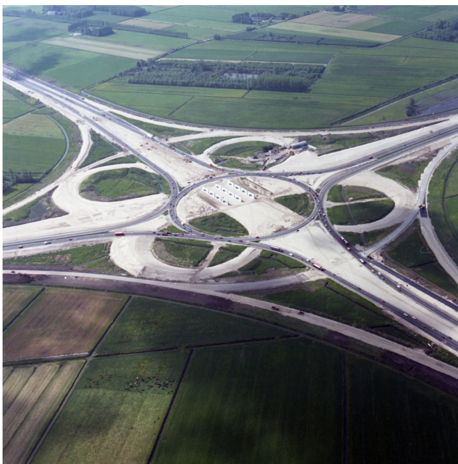
Aanleg verkeersplein Deil (bron https://beeldbank.rws.nl , Rijkswaterstaat / Jaap Boelens)
