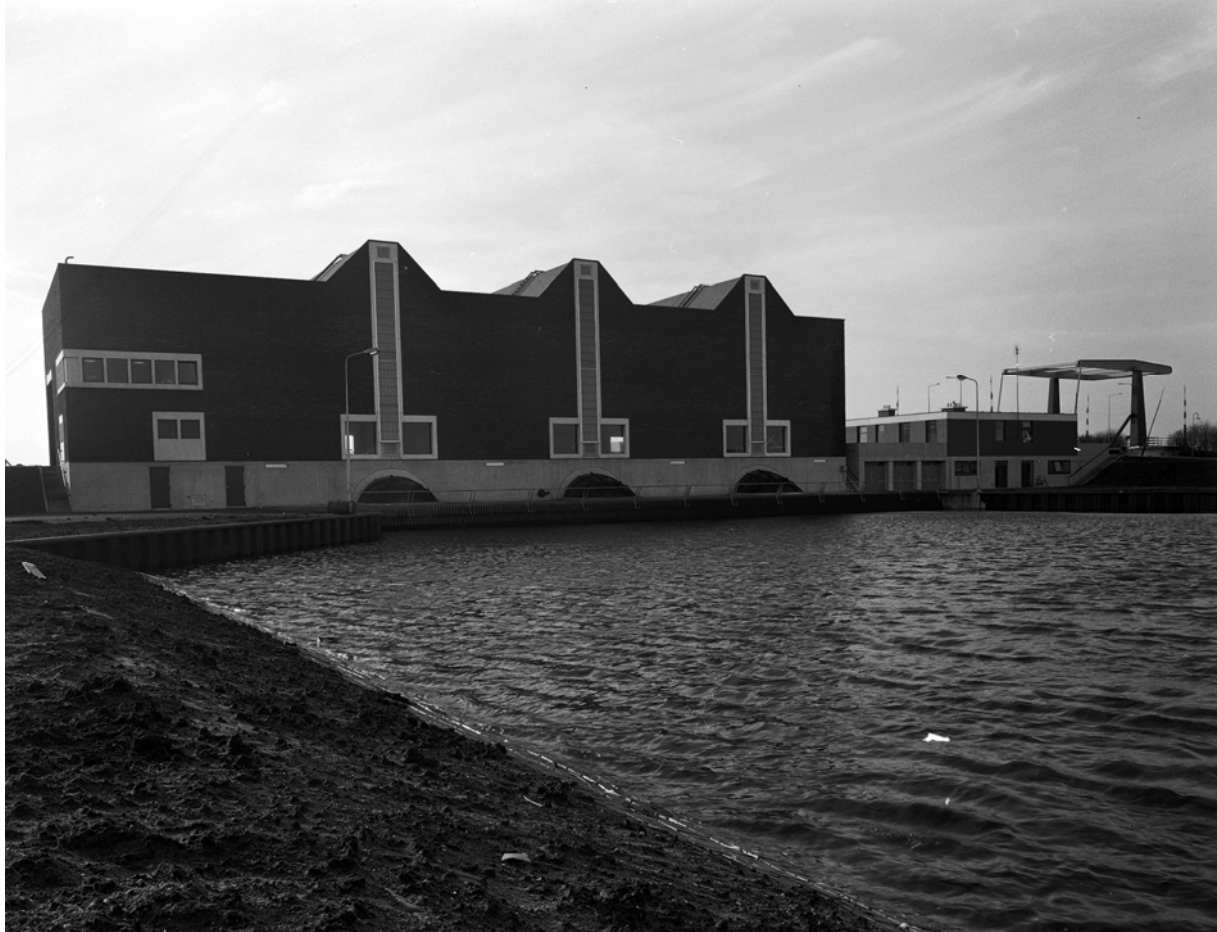
Gemaal Zedemuiden Zwartsluis 1973 (bron https://beeldbank.rws.nl , Rijkswaterstaat / Afdeling
