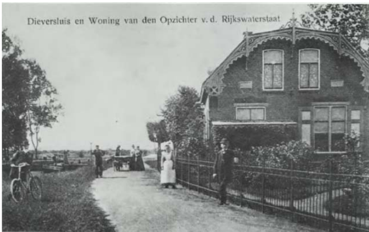
Dienstwoning opzichter (dienstkringhoofd Dieverbrug) 1915 (bron De weg langs de Vaart, de geschiedenis van de weg langs de Drentsche Hoofdvaart van Assen tot Pijlebrug [R.I.P. Nip 1985])
