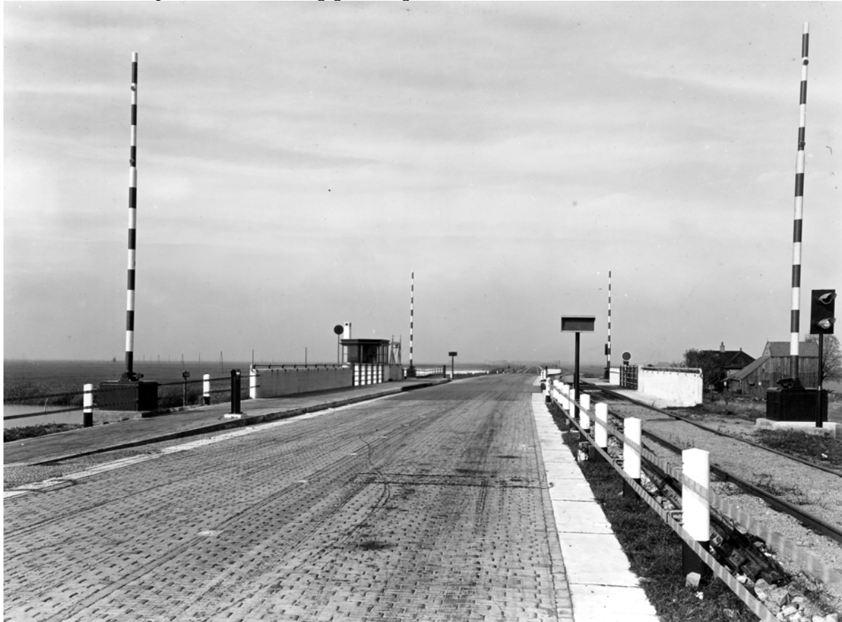
Basculebrug in de oudeweg Joure 1940 (Bron https://beeldbank.rws.nl , Rijkswaterstaat / Afdeling Multimedia Rijkswaterstaat)
