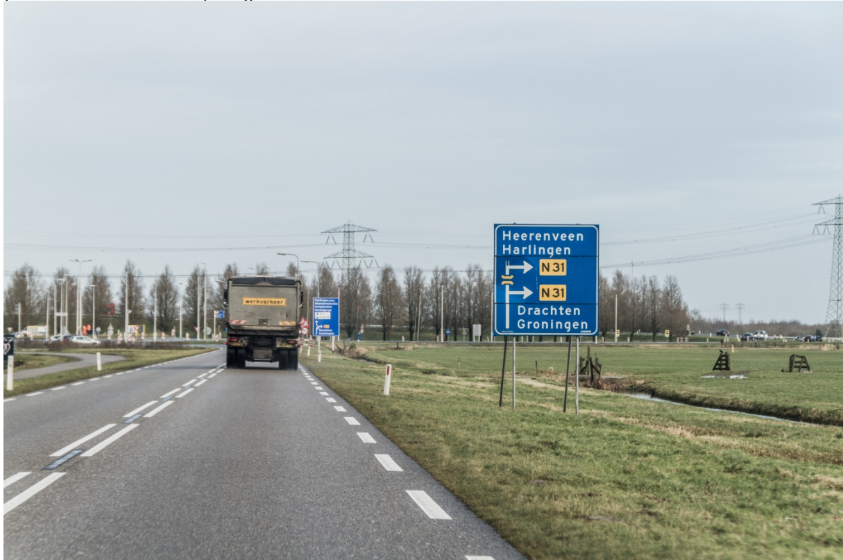
Autoweg N31 in Friesland (bron https://beeldbank.rws.nl , Rijkswaterstaat / Harry van Reeken)
